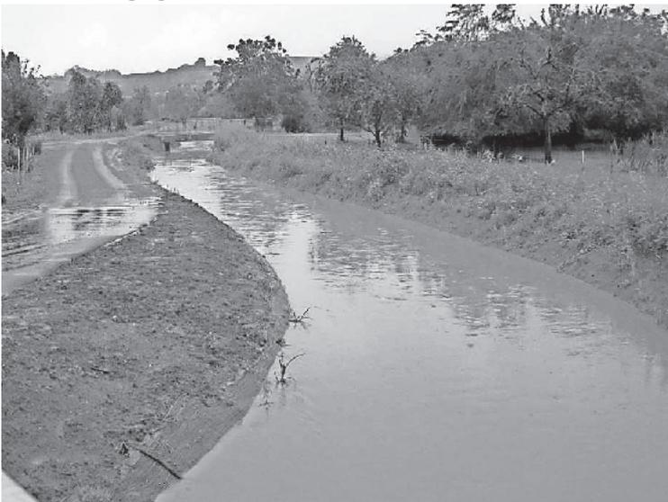
Der Entlastungsgraben zwischen Dorfbach und der Alten Elz ist fertiggestellt. Mit Unterstützung des Landes Baden-Württemberg, vertreten durch das Regierungspräsidium Freiburg, verwirklichte die Stadt Kenzingen mit dem Bau des Entlastungsgrabens die zweite Maßnahme zum Hochwasserschutz im Bereich Hummelberg/Bombacher Tal.
